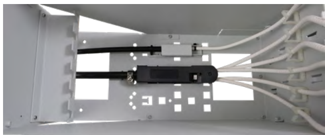
iSER-C équipé de deux arrimages de câble
