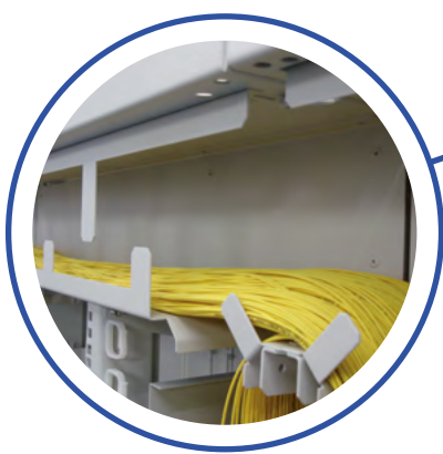
Goulottes pour communication horizontale entre répartiteurs juxtaposés
