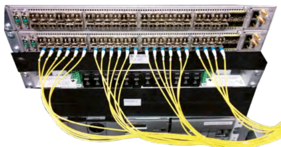
Exemple de raccordement en face avant d'équipement
