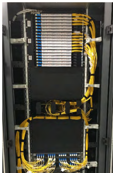
Résorbeur horizontal 3U intégré en baie 19"
