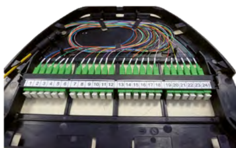
Exemple de raccordement dans un tiroir iTOM-V3
