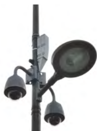
Fixation sur candélabre
